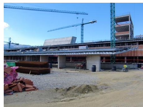
Figura 1. Hospital de la Cerdanya
